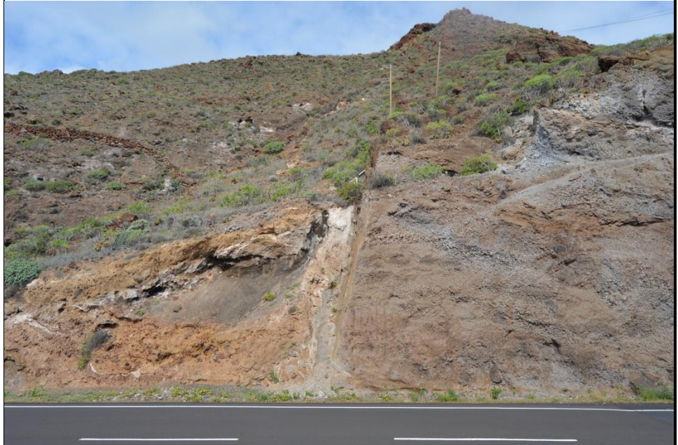
Foto 1. Vista desde el Este de la falla de San Andrés en la carretera de Valverde al Puerto de la Estaca, en el Morro del Jayo.
