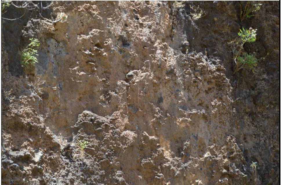
Foto 5 Detalle de la Fotografía 4. En el plano de falla puede observarse la presencia de una roca de falla, de cataclastitas y de un espejo de falla con escalones y estrias. Estas estructuras nos indican un movimiento, fundamentalmente en la vertical con descenso del bloque de techo hacia el Noroeste.
