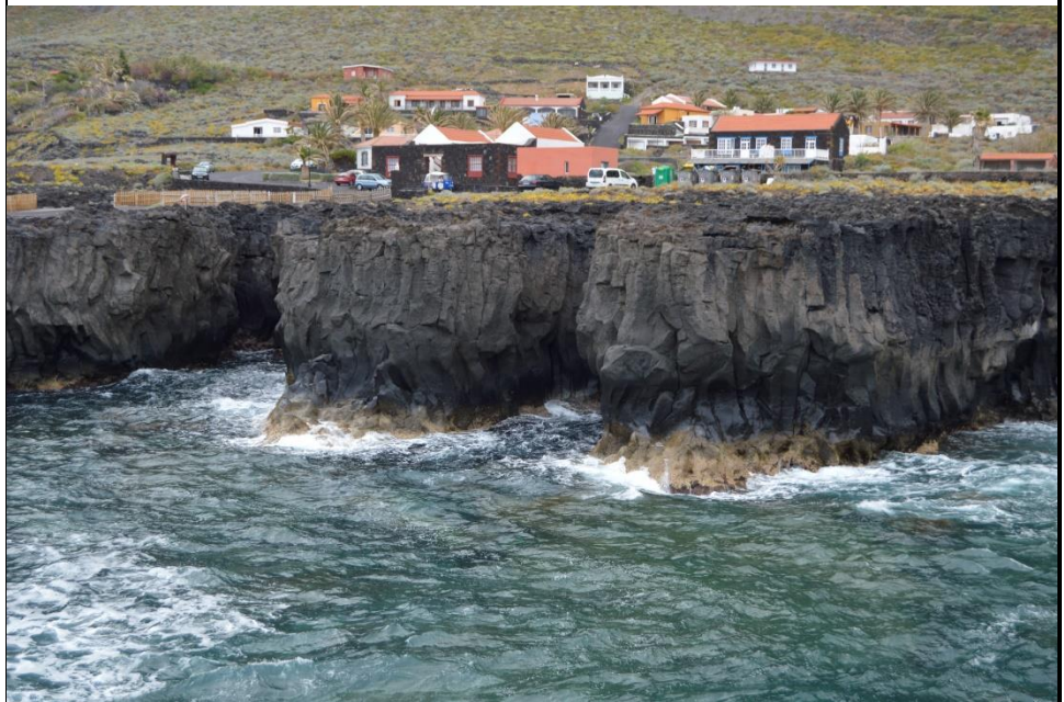
Foto 4. Vista de la costa desde el arco de La Lajita hacia el Sureste. Se trata de tres antiguas cuevas, perpendiculares a la costa, que sufrieron el desplome de sus techos, dando lugar a las tres "puntas". do un desplome de su parte central (en primer término) y su parte más profunda (al fondo, agujero limitado por vallas de madera). Nótese la estructura de las coladas: en la parte baja aparecen unas columnas muy apretadas de base hexagonal o cuadrada que pasan, a través de una entablatura, en la parte media, a unas columnas superiores de base también cuadrada o hexagonal.
