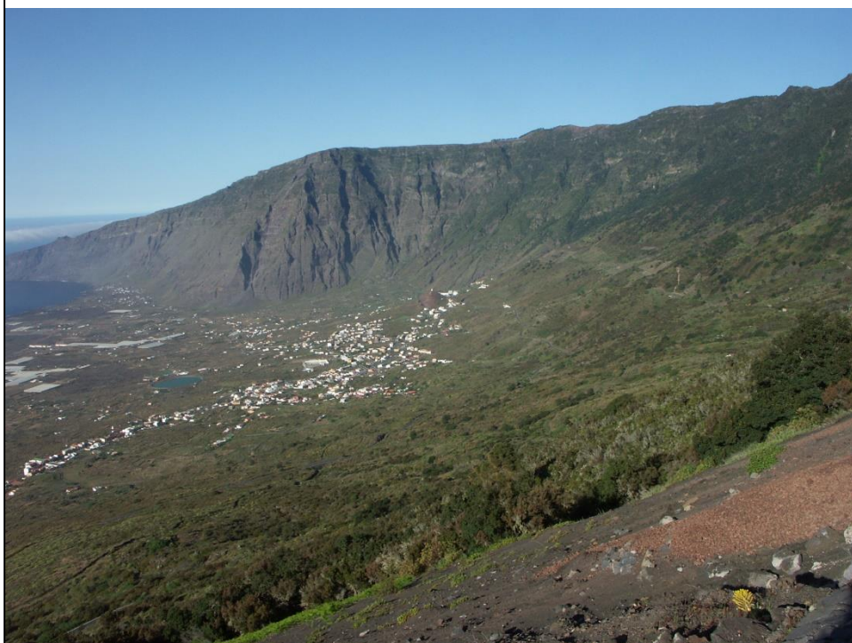
Foto 3. Vista, desde el Oeste, del sector central del Valle de El Golfo en el que se aprecia el escarpe del 2º deslizamiento ocurrido hace 23.500 años.
